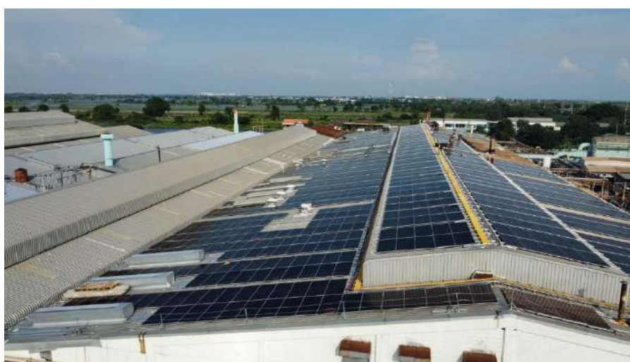
โครงการ ติดตั้ง Solar rooftop
